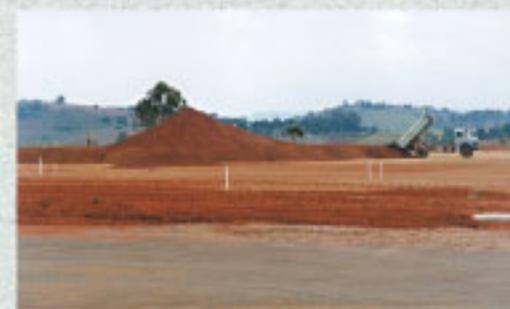
Foto 5 – Material reciclado depositado ao lado da obra
