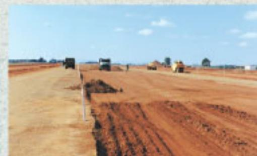
Foto 4 – Material do subleito sendo escarificado
