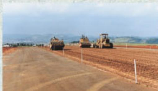
Fotos 6 – Nova base reciclada, compactada e imprimada
