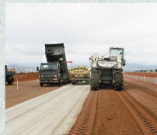
Foto 3 – Fresagem com incorporação do agregado mineral
