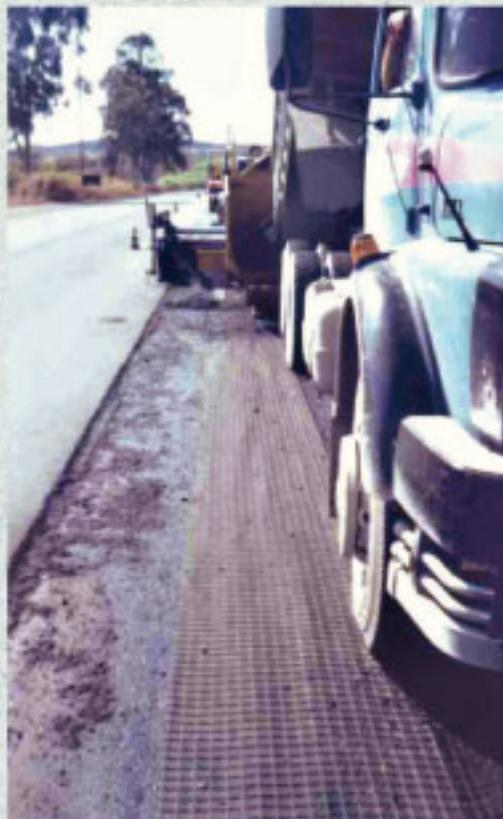
*Execução do revestimento betuminoso. Detalhe da geogrelha fixada sobre a junta longitudinal da camada reciclada*
